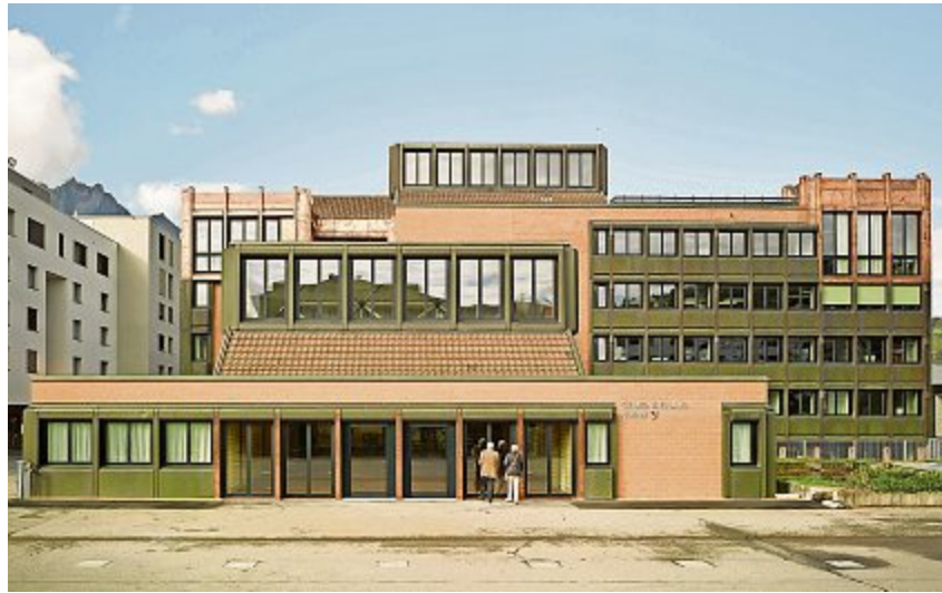
Das sanierte und erweiterte Gemeindehaus Horw.
